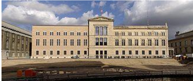
Westfassade des Neuen Museums 2009
