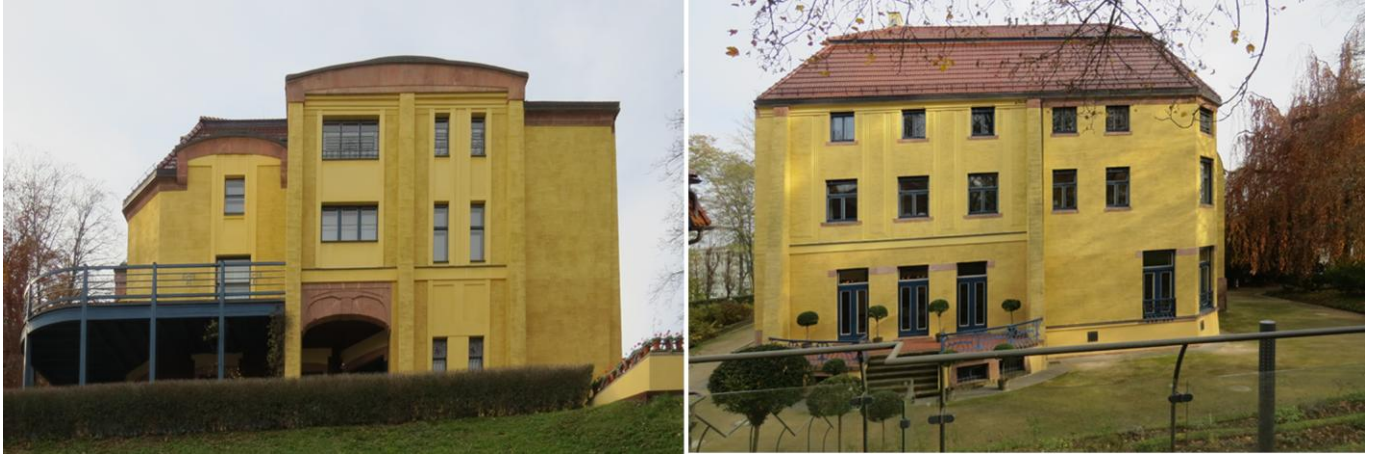
Die rekonstruierte Villa Esche in Chemnitz
