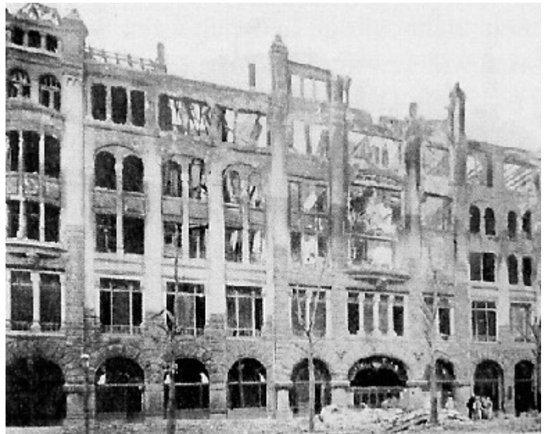
Das während des Kapp-Putsches zerstörte Volkshaus
